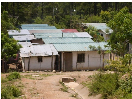
Fig. #2 Nuevas viviendas construidas por la empresa minera para reubicar a las comunidades.
