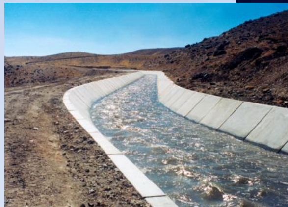
Canal colector Ingahuasi Huancavelica, Perú
