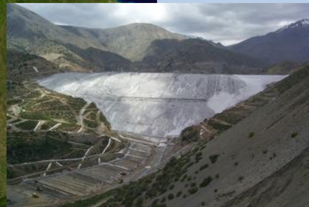
Tranque de relaves "Los Pelambres" Coquimbo, Chile
