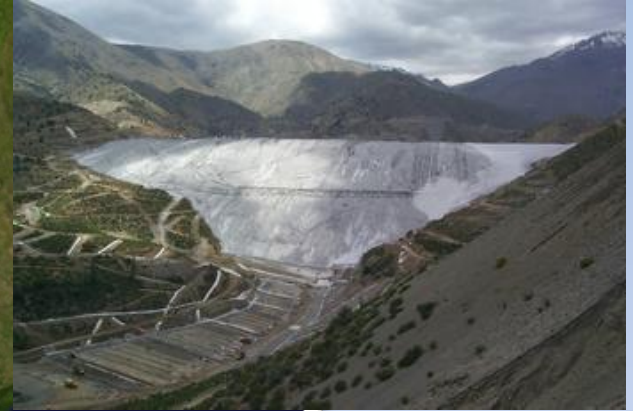
Tranque de relave "Los Pelambres" Coquimbo, Chile
