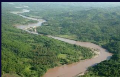
Proyecto Hidroeléctrico "La Parota"
